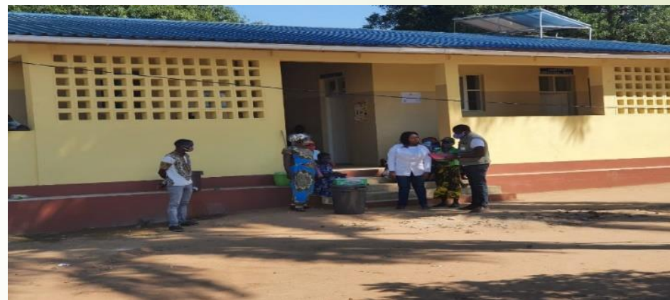
Novo bloco – expansão do CS Munhamade
